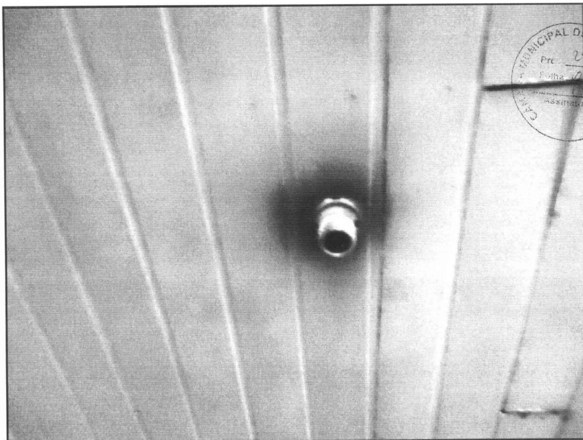
FOTO 03. Foco de princípio de incêndio no bocal da lâmpada.
