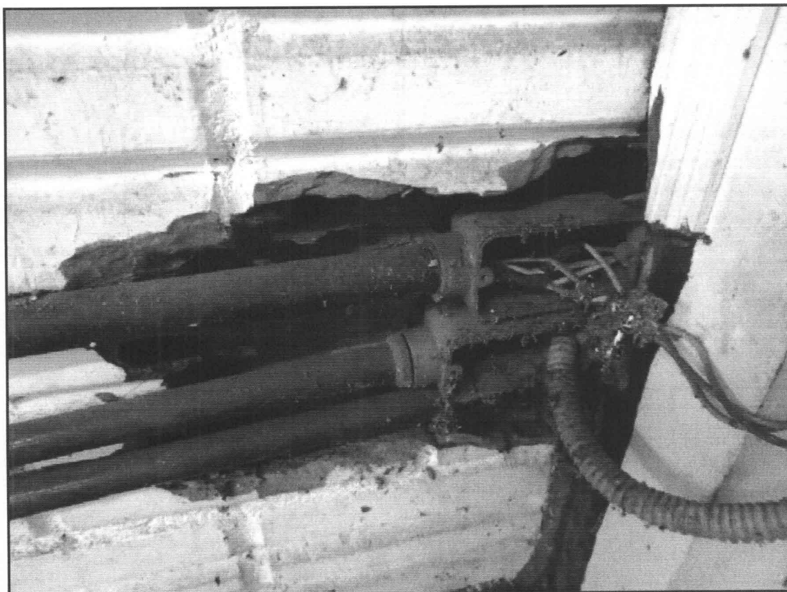
FOTO 06. Rede elétrica em precárias condições na presença de improvisações.
