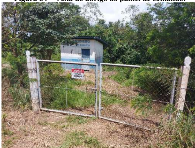
Figura 84 – Vista do abrigo do painel de comando.
