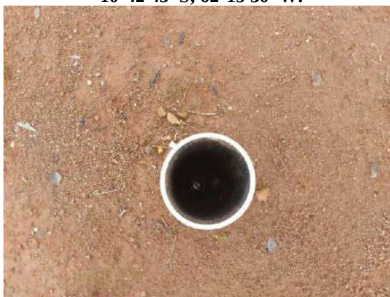
Figura 73 – Local do registro de manobra de gaveta DN 150 mm na rua Princesa Isabel, coord. 10°42'45"S; 62°15'30"W.
