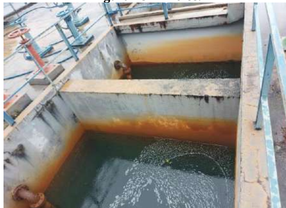
Figura 50 – Registros de descargas dos decantadores F°F° 75mm.
