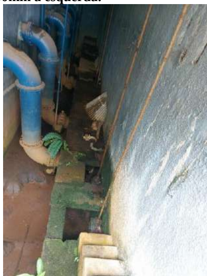
Figura 49 – Registros de descargas dos filtros F°F° 100mm a direita e do reservatório de contato de F°F° 250mm a esquerda.
