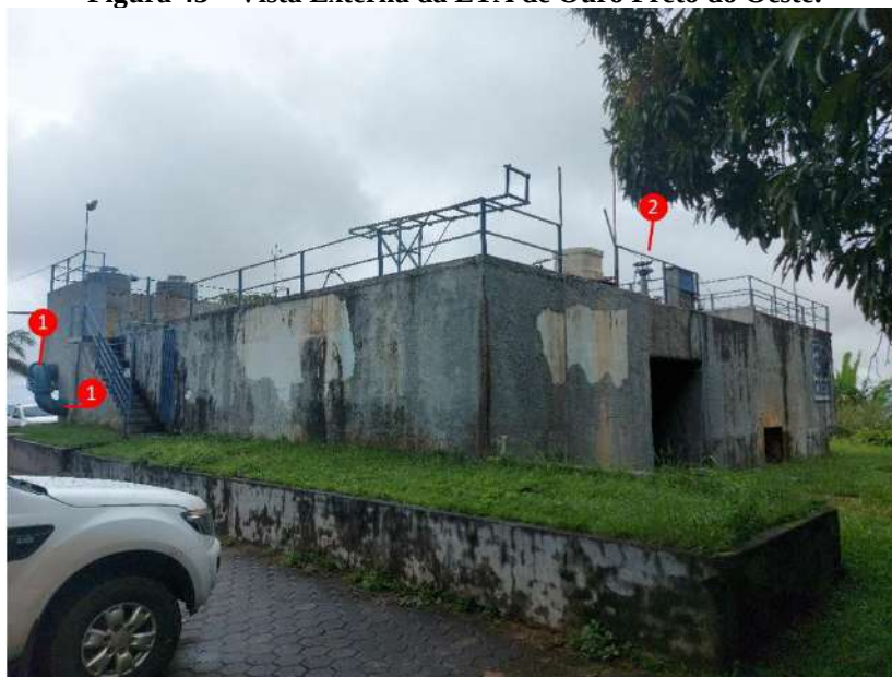
Figura 43 – Vista Externa da ETA de Ouro Preto do Oeste.
