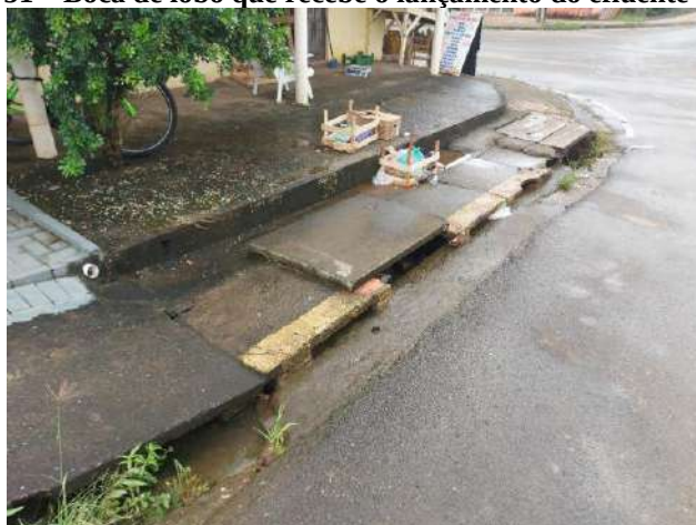
Figura 51 – Boca de lobo que recebe o lançamento do efluente da ETA.
