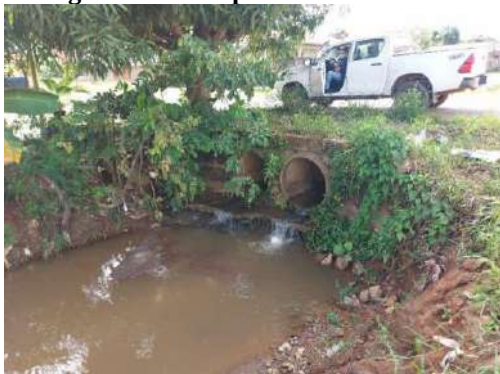
Figura 115 – Dispositivos de macrodrenagem da Sede de Ouro Preto do Oeste – Canal 5.
