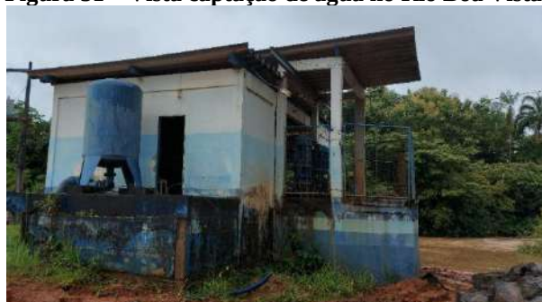
Figura 31 – Vista captação de água no Rio Boa Vista.
