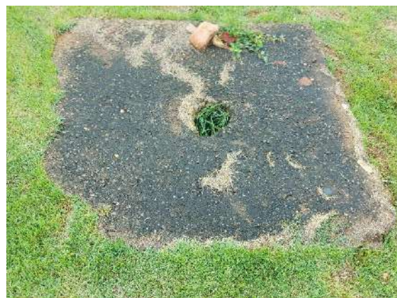
Figura 72 – Local do registro de manobra de gaveta DN 250 mm na rua Jucelino Kubtscheck, coord. 10°42'43"S; 62°15'27"W.
