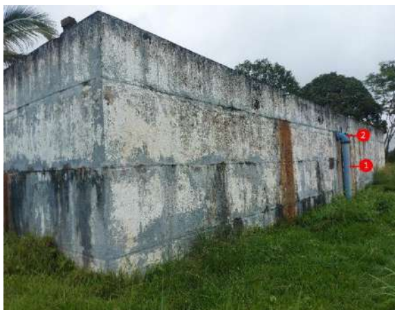
Figura 61 – Alimentação do Reservatório 01.
