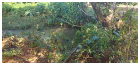
Figura 117 – Dispositivos de macrodrenagem da Sede de Ouro Preto do Oeste – Canal 6.
