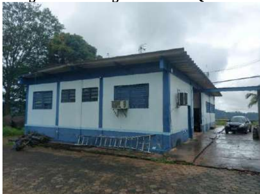
Figura 53 – Abrigo da Casa de Química.
