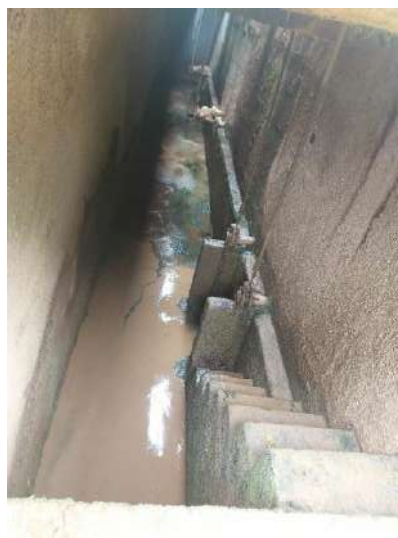
Figura 50 – Registros de descargas dos decantadores F°F° 75mm.
