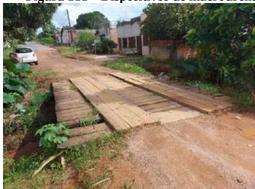
Figura 111 – Dispositivos de macrodrenagem da Sede de Ouro Preto do Oeste – Canal 3.
