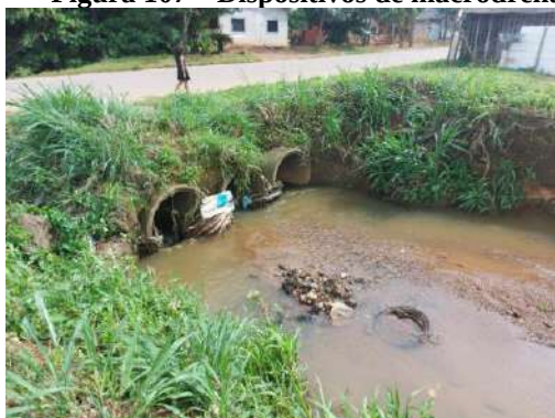
Figura 107 – Dispositivos de macrodrenagem da Sede de Ouro Preto do Oeste – Canal 1.
