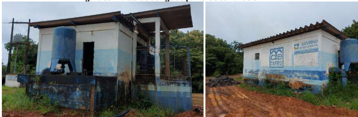
Figura 39 – Vista do abrigo do painel de comando e EEAB.
