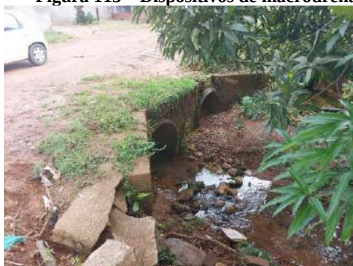
Figura 113 – Dispositivos de macrodrenagem da Sede de Ouro Preto do Oeste – Canal 4.
